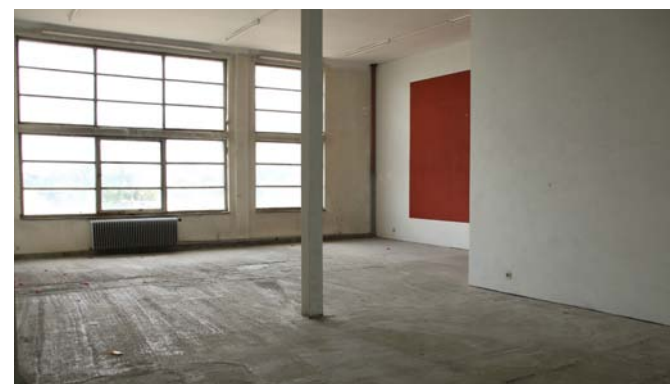
Blik op de “Salle des Disjoncteurs” vóór herinrichting en restauratie.
