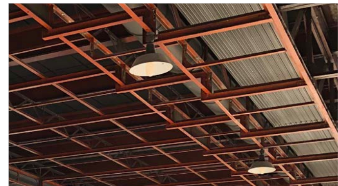
Originele werkende armaturen op +5
